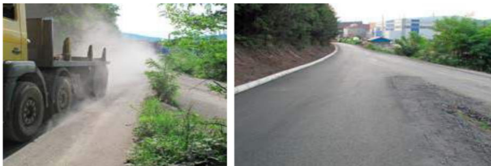
Slika 10: Cesta na Haldo pred in po sanaciji
