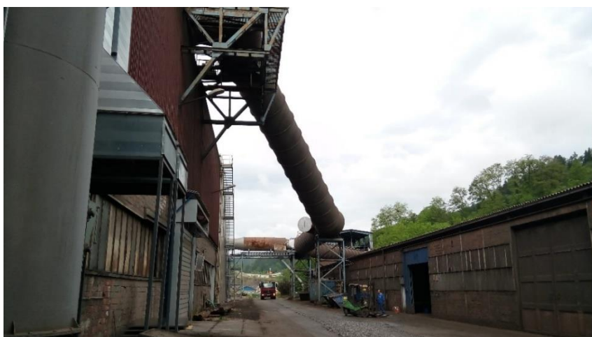
Slika 19: Cev, ki povezuje vse zgradbe jeklarne s silosom odpraševalne naprave Vir: Šturbaj, 2016
