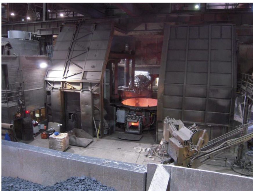
Slika 17: Elektroobločna peč EOP-UHP z odprto protihrupno komoro "doghouse"
