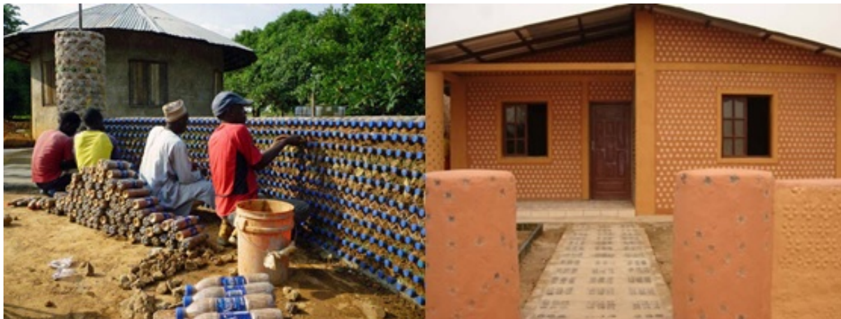
Slika 6: Gradnja hiše iz plastenk v Nigeriji. Vir: Andreas Froese/ECOTEC.
