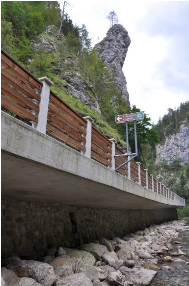
Slika 19: Pod cesto je speljana drenaža za odvod vode iz območja studenca Foto: P. Skoberne.
