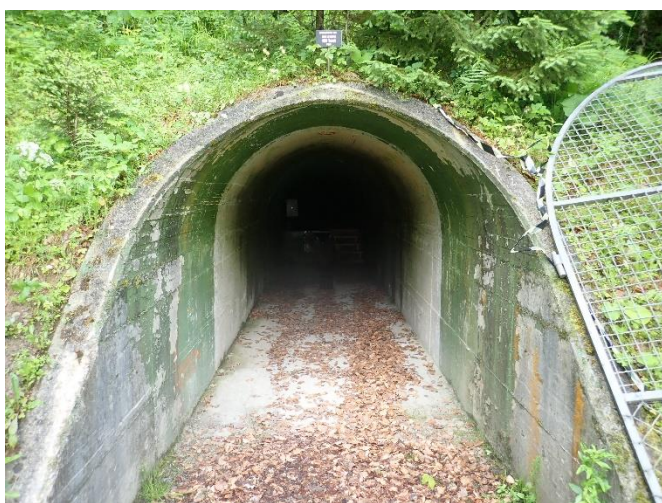
Slika 8: Vhod v drenažni rov.
