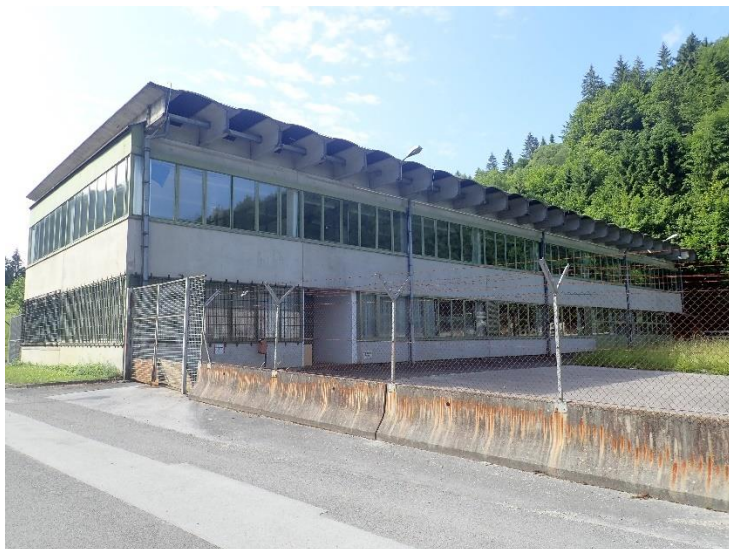
Slika 5: Ena redkih stavb (ob vhodu P-10), ki v postopku zapiranja rudnika ni bila porušena, sedaj v lasti Ministrstva za obrambo Republike Slovenije.
