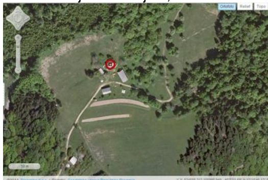
Slika 44: Ortofoto obnovljenega objekta v KS Jurklošter v naselju Lahov Graben (Vir: Geopedija, 2012)
