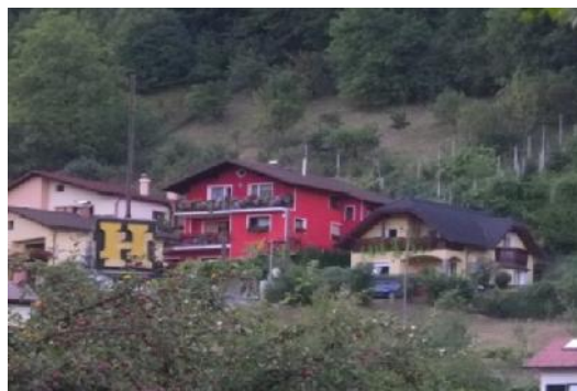
Slika 29: Obnovljen objekt v KS Laško, v naselju Pod šmihel (Vir: Avtorica, 2012)
