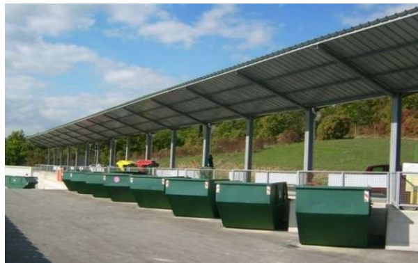
Slika 4: Zbirni center ločenih frakcij komunalnih odpadkov (Vir: Okolje Piran, 2018)
