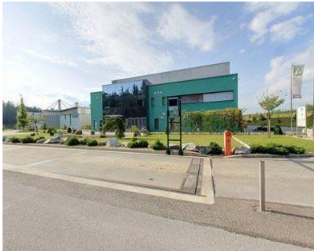
Slika 18: Poslovna stavba podjetja Kocerod, d. o. o. (Vir: Lasten)
