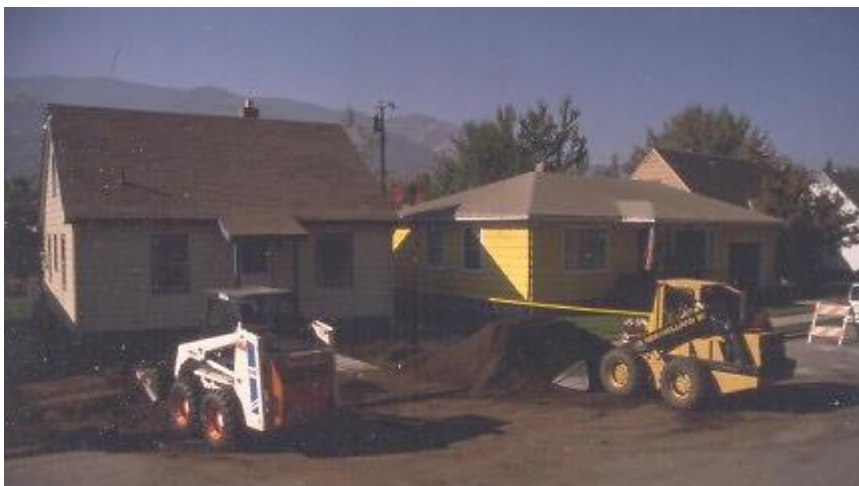
Slika 9: Zamenjava onesnažene zemlje (vir: Zavod za zdravstveno varstvo Ravne na Koroškem, b. l.).
