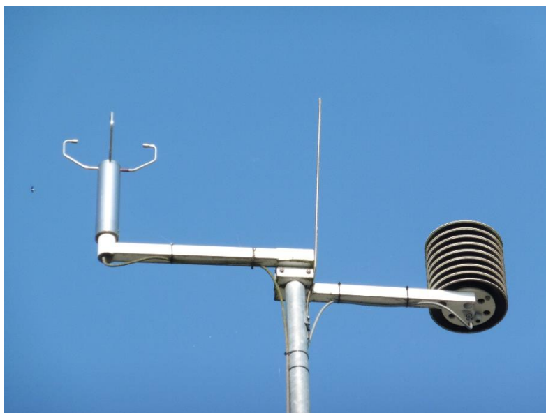
Slika 32: Del merilne postaje NEK – Stolp; levo na sliki je merilnik za hitrost vetra, desno merilnik za merjenje vlage in temperature zraka
