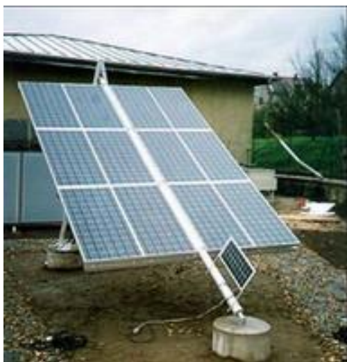
Slika 12: Enoosna sledilna naprava [16]
