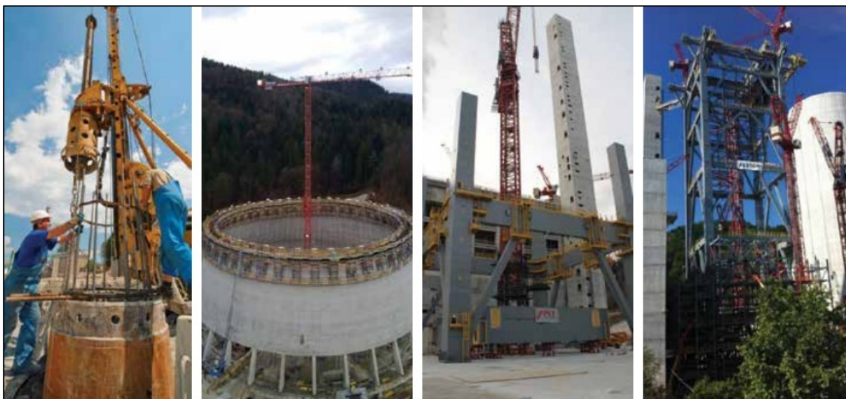
Slika 2: Gradnja šestega bloka TEŠ (TEŠ, 2016)
