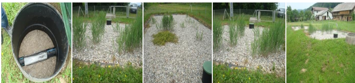
Slika 9: Rastlinska čistilna naprava Podboč (foto: N. Pučnik, 2018)
