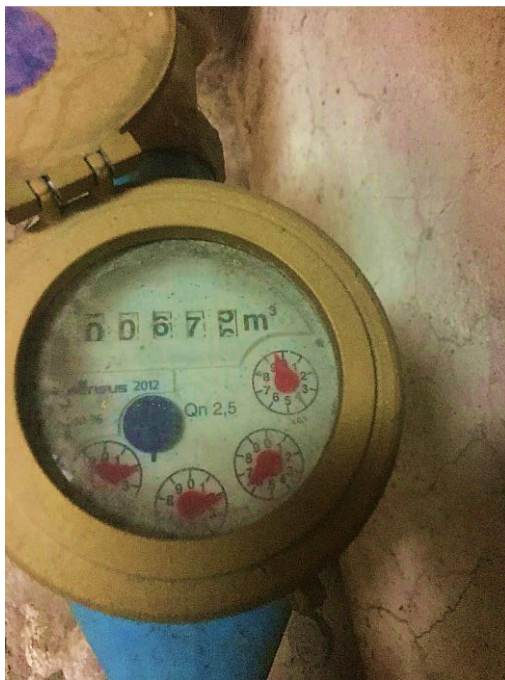
Slika 5: Števec mrzle vode zadnji dan meritev (foto: K. Valentina, 2017)
