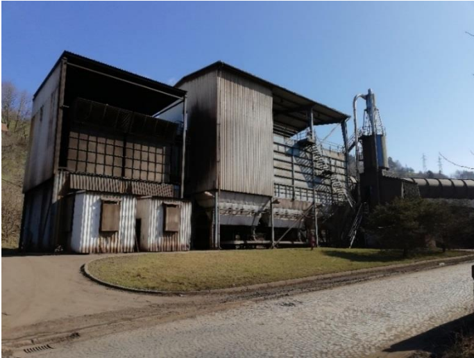
Slika 4: Odpraševalna naprava za elektroobločno peč
