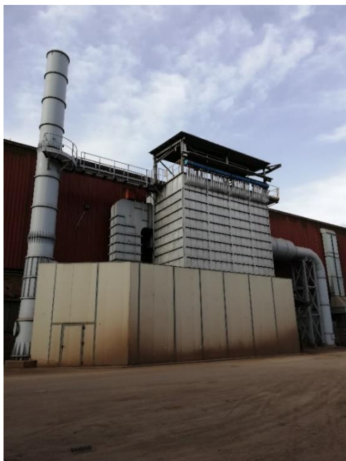
Slika 6: Odsesovalna naprava za vakuumske ponovne peči
