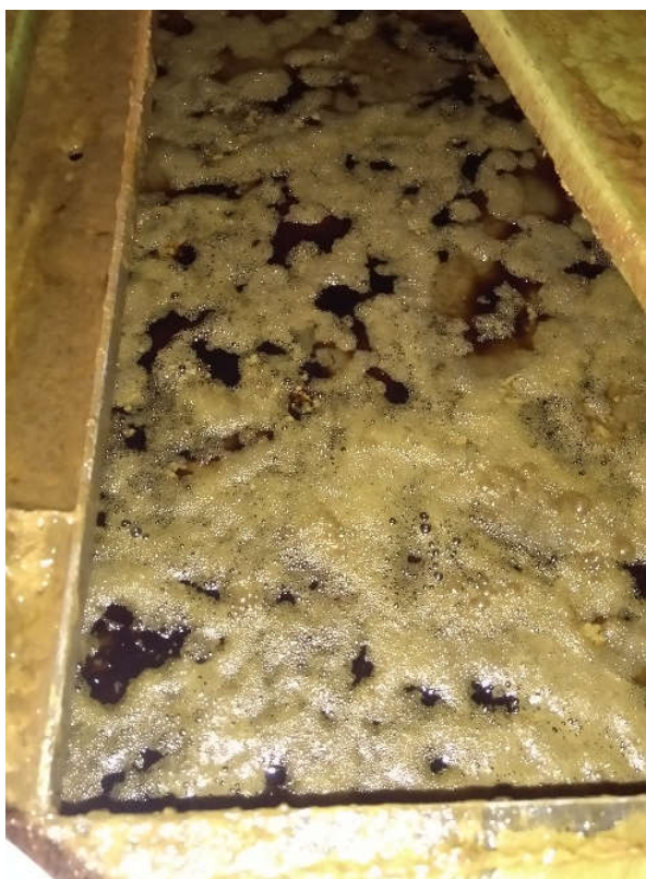
Slika 17: Kondenzirani hlapi organskih spojin in druge nečistoče na površini vode v čistilni napravi
