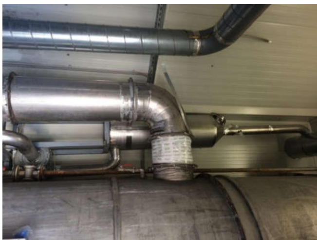
Slika 13: Splošni primer vgradnje segmenta filtra z aktivnim ogljem na oddušno cev Vir: enviTEC Technologie GmbH, 2017
