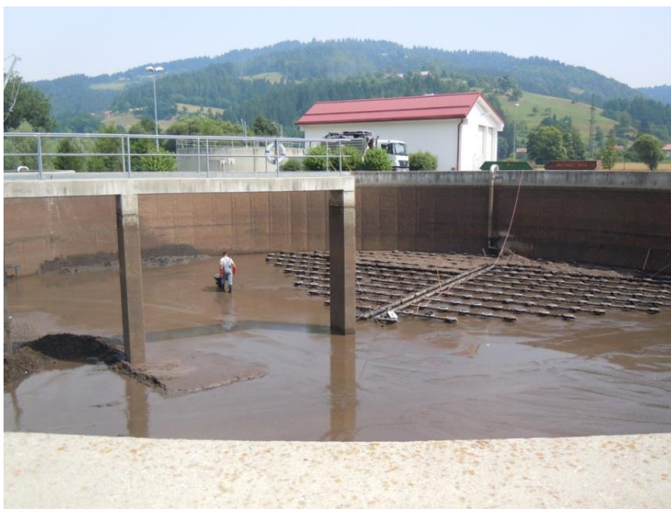
Slika 13: Čistilna naprava Slovenj Gradec, čiščenje prezračevalnega bazena Vir: Lasten vir (3.7.2012).
