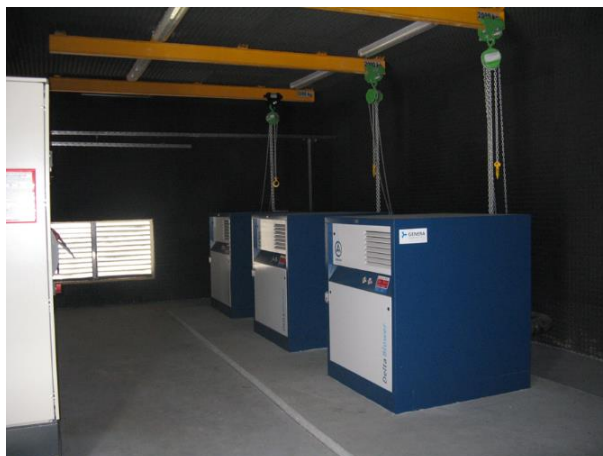
Slika 10: Puhala v kompresorski postaji (vir: arhiv Komunale Trbovlje d.o.o., 2012)
