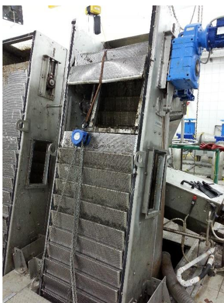
Slika 19: Fine grablje med popravilom (vir: osebni arhiv)
