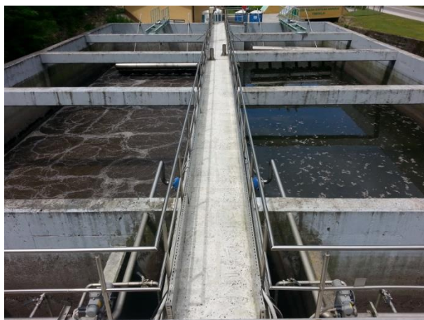
Slika 5: Sekvenčna bazena, levi v fazi vtoka in aeracije ter desni v fazi usedanja (vir: osebni arhiv)
