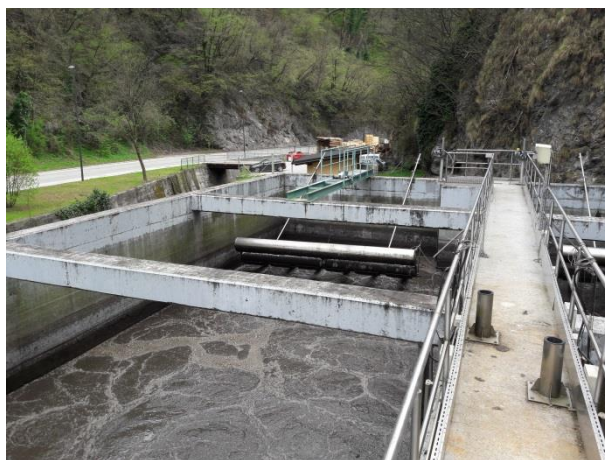
Slika 21: Sistem mehanskega prilagajanja nivoja dekanterjev (vir: osebni arhiv)
