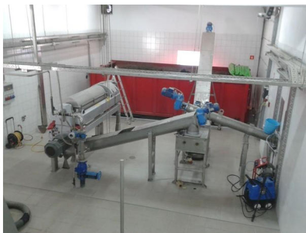
Slika 7: Centrifuga za dehidracijo blata in transportni postroj z zabojnikom (vir: arhiv Komunale Trbovlje d.o.o., 2012)
