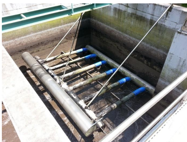
Slika 6: Prelivnik v sekvenčnem bazenu (vir: osebni arhiv)
