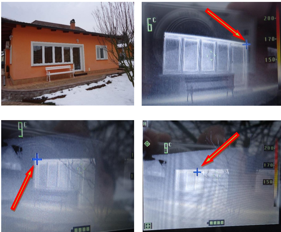
Slika 30, 31, 32, 33: Zahodna lega objekta in temperaturne izgube (Vir: lastni slikovni vir, 2015)
