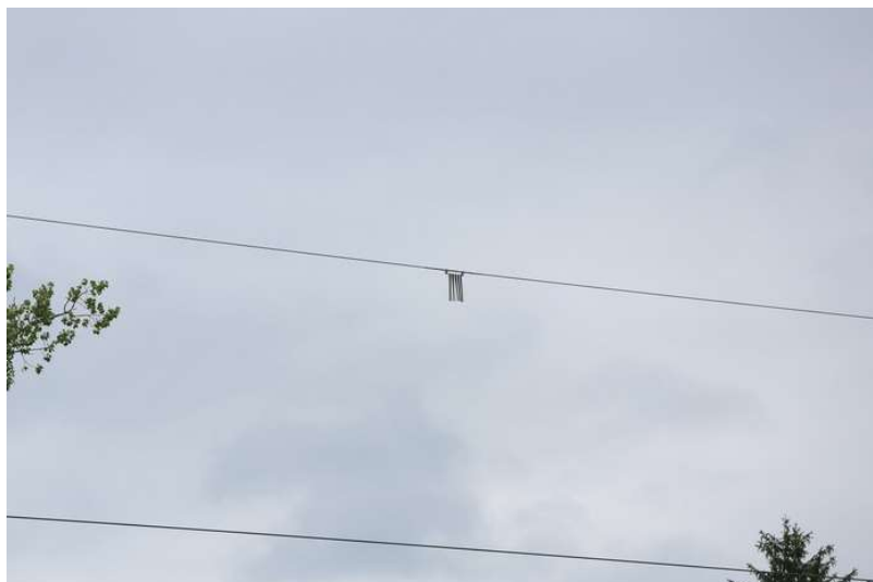
Slika 5: Označevalcec vodnika visokonapetostnega daljnovoda Vir: ELES, 2017
