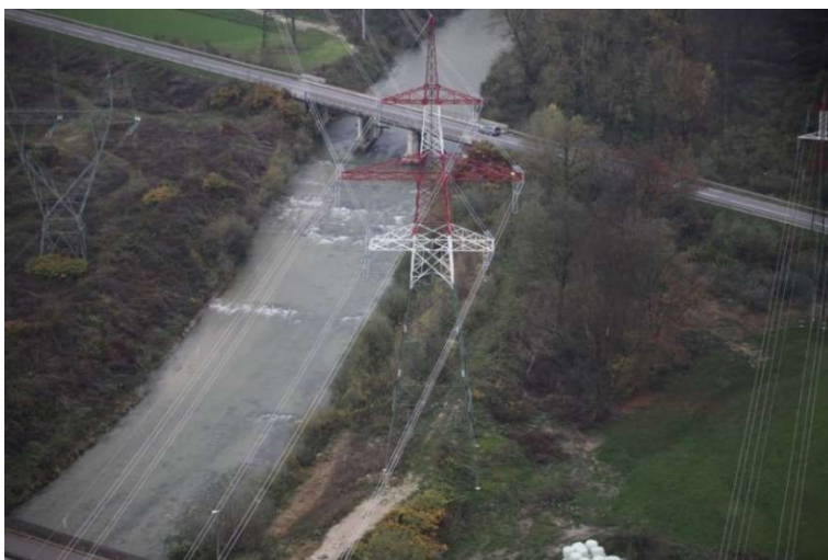
Slika 9: Kontrastno obarvan steber na trasi DV 2 x 400 kV Beričevo - Krško Vir: ELES, 2017
