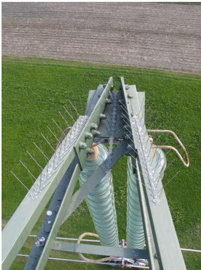
Slika 6: Odvračalci ptic, nameščeni na daljnovodnem stebru Vir: ELES interno, 2017
