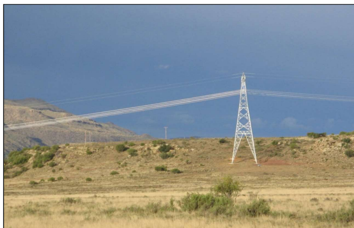
Slika 8: Portalni tip stebra z manjšim številom nivojev vodnikov Vir: Koče in sod., 2012
