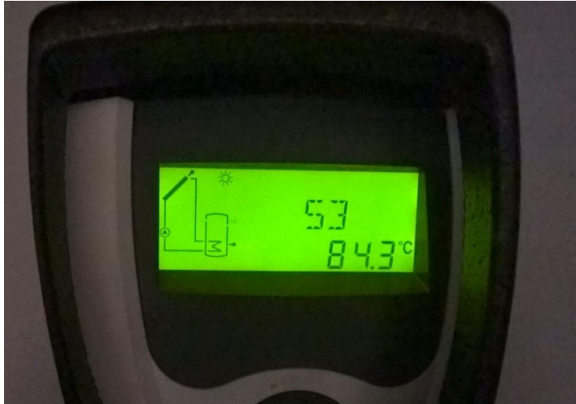
Slika 19: Prikaz zgornje temperature v zalogovniku vode (Vir: lasten)
