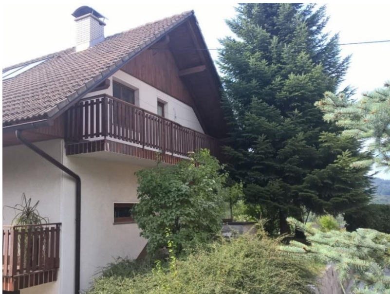
Slika 15: Vzhodna stran objekta (Vir: lasten)
