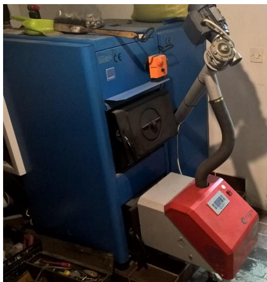
Slika 18: Peč na drva in pelete (Vir: lasten)
