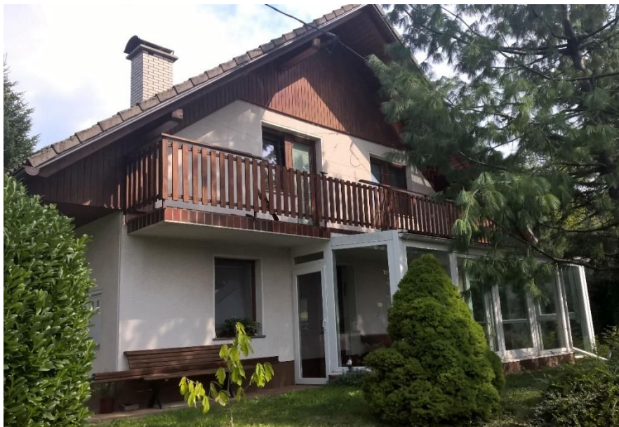
Slika 17: Vzhodna stran objekta (Vir: lasten)
