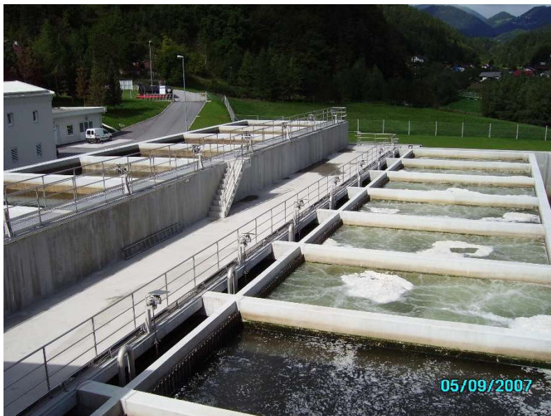
Slika 16: Biofiltracija (Vir: Štramcar, 2008, 32)
