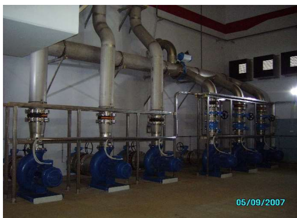
Slika 18: Črpalke za recikel (Vir: Štramcar, 2008, 34)
