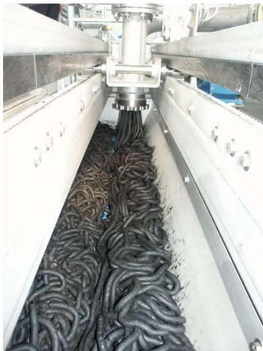
Slika 10: Prikaz doziranja blata na tračno sušilnico (Vir: Poslovnik za obratovanje sušilnice blata CČN Novo mesto, 2015, 23)
