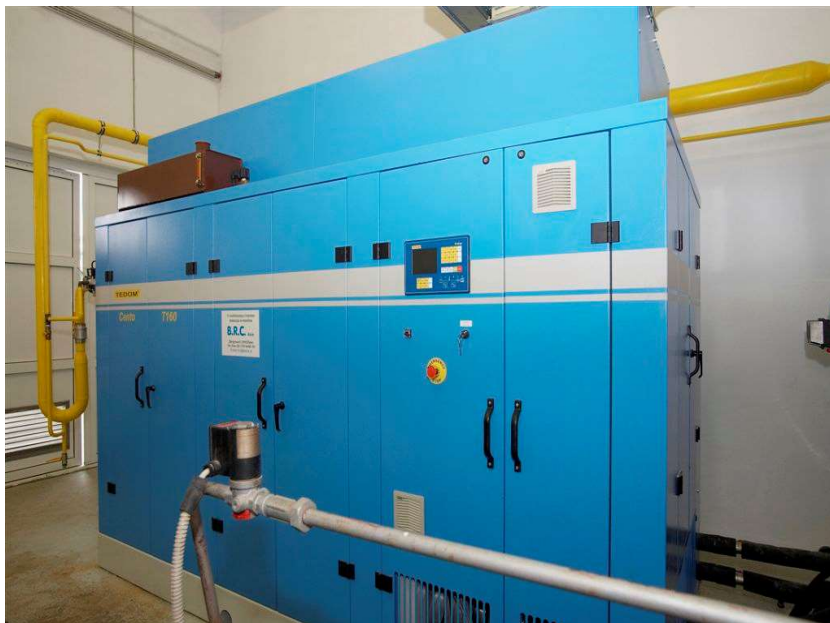
Slika 25: Plinski motor s kapaciteto 150 kW (Vir: Štramcar, 2008, 40)
