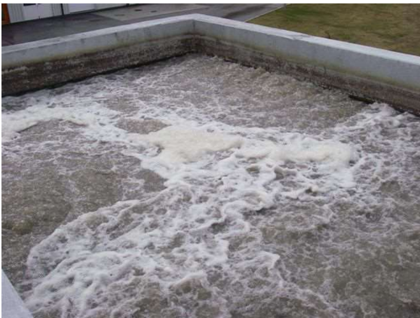
Slika 20: Biofilter v procesu pranja (Vir: Štramcar, 2008, 35)
