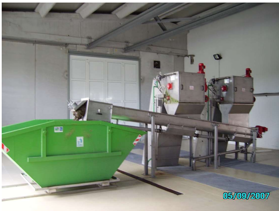
Slika 13: Fine grablje (Vir: Štramcar, 2008, 29)
