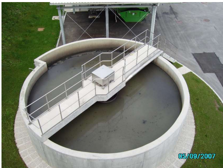
Slika 22: Zgoščevalnik blata (Vir: Štramcar, 2008, 37)
