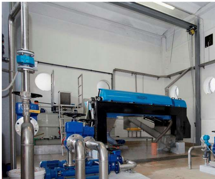
Slika 24: Centrifuga (Vir: Štramcar, 2008, 39)
