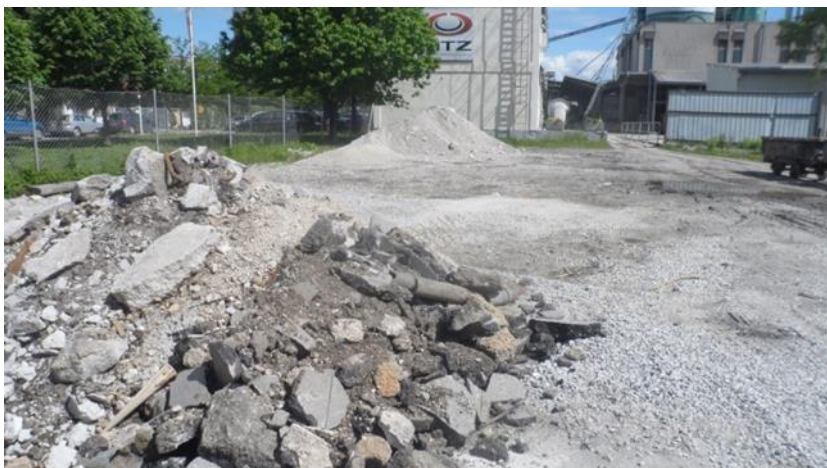
Slika 16: Začasna deponija izkopanega materiala.
