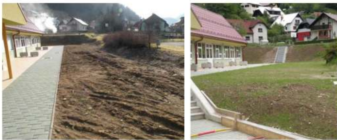
Slika 1: Zamenjava onesnažene zemlje pri Osnovni šoli Črna na Koroškem (Vir: Medmrežje 3)
