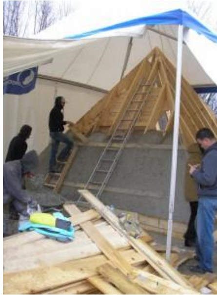
Slika 3: Gradnja prve zgradbe iz konopljinega cementa pri nas. Avtorja piramide pri Žalcu sta Henry Thompson in Borut Šket.
