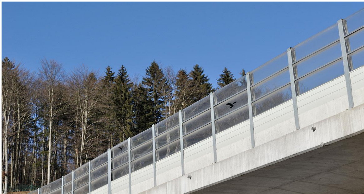
Slika 13: Primer transparentne protihrupne ograje (Vir: Medmrežje 15)
