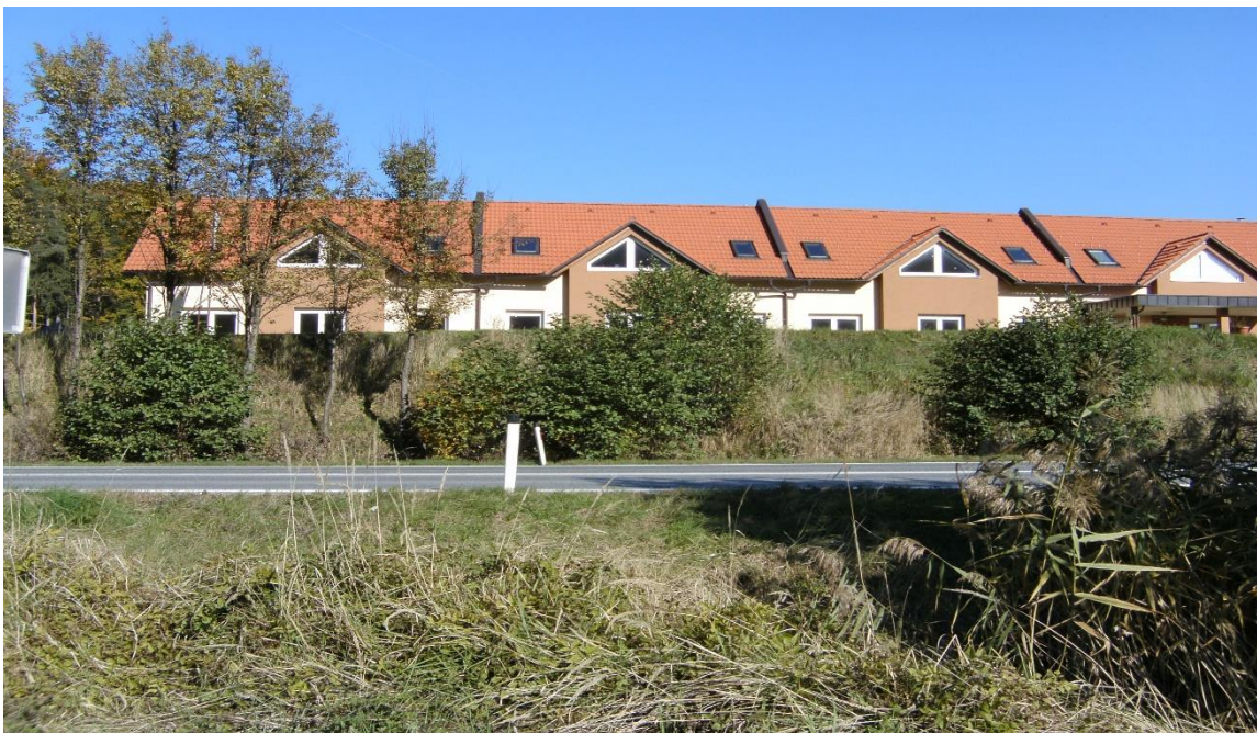
Slika 22: Zatravljen zemeljski protihrupni nasip ob cesti Arja vas–Velenje v naselju Bevče (Vir: Lasten)
