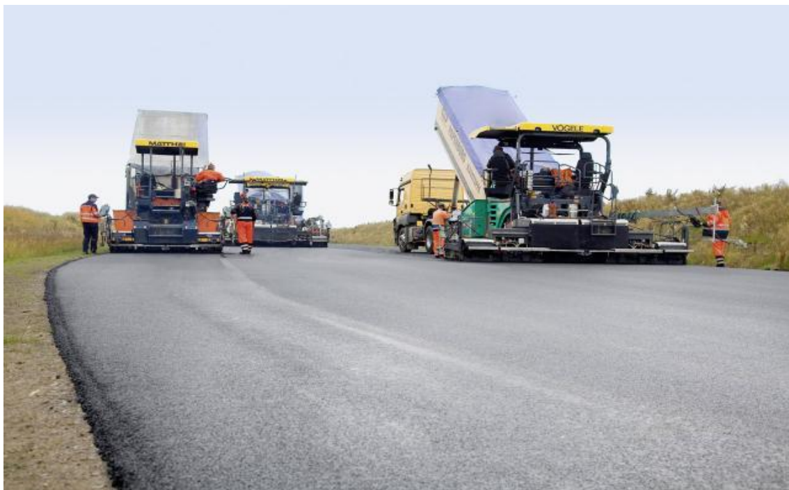
Slika 5: Vozna površina z asfaltno zmesjo bitumenskega betona BB 11s (Vir: Medmrežje 6)
