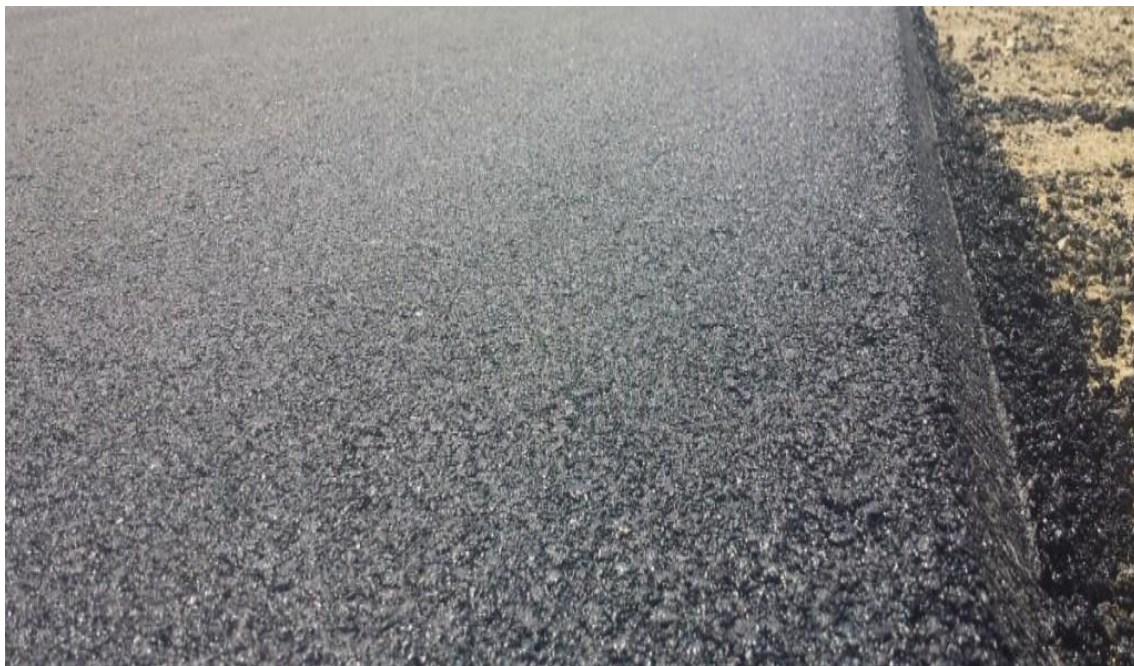
Slika 4: Vozna površina z asfaltno zmesjo iz drobirja v bitumenskem mastiksu DBM 8s (Vir: Medmrežje 5)
