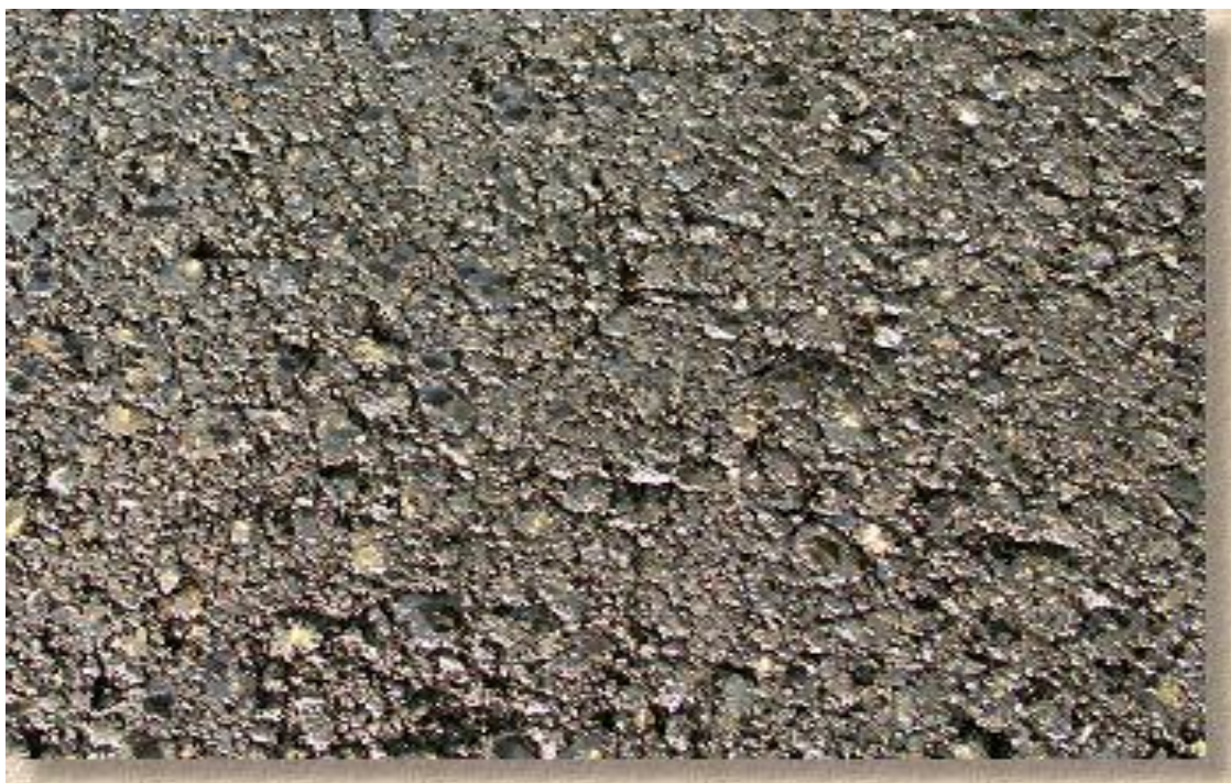
Slika 3: Vozna površina z asfaltno zmesjo iz drobirja v bitumenskem mastiksu DBM 11s (Vir: Medmrežje 4)
