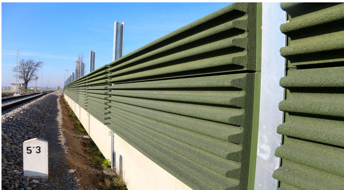
Slika 11: Primer betonske protihrupne ograje (Vir: Medmrežje 13)
