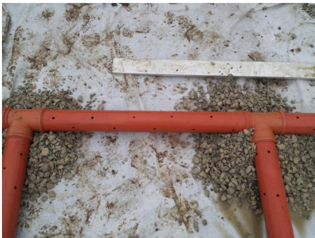
Slika 17: Ročno nasipavanje substrata okoli drenažnih cevi
