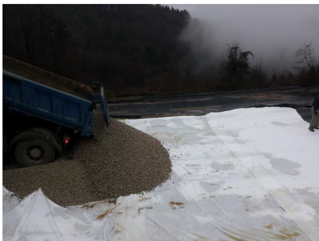
Slika 16: Nasipavanje substrata
