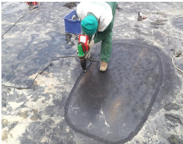
Slika 14: Varjenje zaščitne folije
