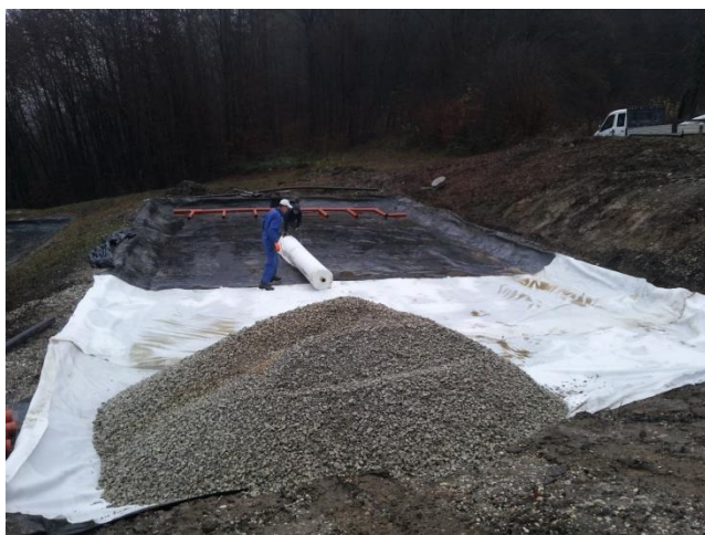
Slika 15: Polaganje filca in drenažnih cevi
