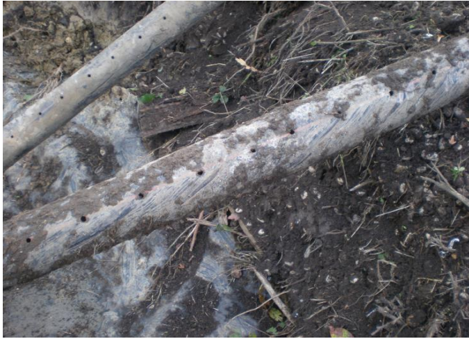
Slika 11: Drenažne cevi, ki so se nahajale v rastlinski čistilni napravi Studenec
