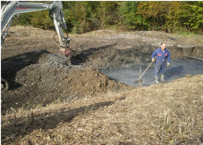
Slika 12: Odstranjevanje substrata
