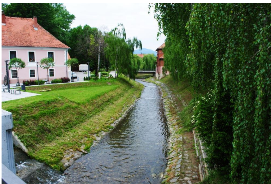
Slika 2: Regulirana struga reke Dravinje v Slovenskih Konjicah Vir: Tepej 2015
