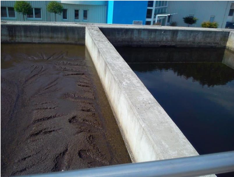
Slika 11: Biofilter z napihnjeno glino v primerjavi z normalno delujočim (Vir: Avtor, 2013).
