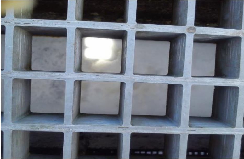
Slika 9: Jašek, kamor se preliva pralna voda (Vir: Avtor, 2013).
