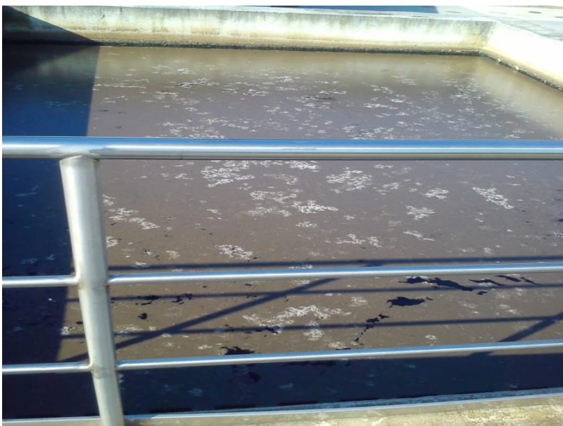
Slika 13: Bazen, pokrit s plavajočim blatom v celoti (Vir: Avtor, 2013).
