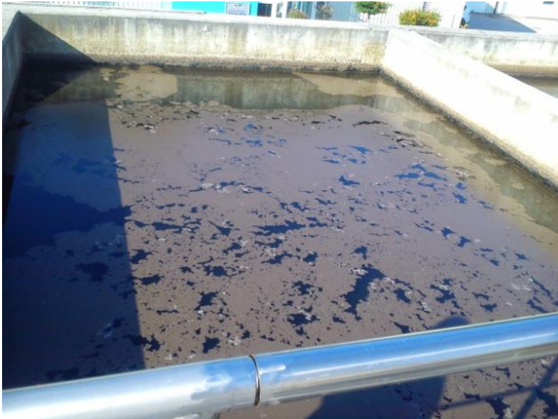
Slika 12: Delno pokrit bazen s plavajočim blatom (Vir: Avtor, 2013).
