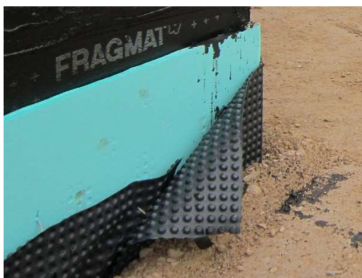
Slika 14: Zaščita hidroizolacijskega sistema s čepastimi membranami in stiropornimi ploščami Vir: Fragmat Tim d.d., 2012
