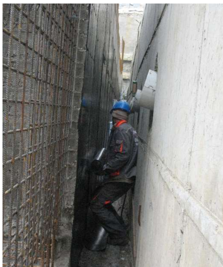
Slika 13: Primerni gradbeni teren za vgradnjo samolepilnega hidroizolacijskega traku Vir: Fragmat Tim d.d., 2014
