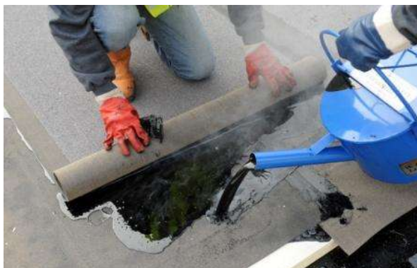
Slika 12: Vgradnja hidroizolacijskih sistemov z vročo bitumensko podlivno lepilno zmesjo Vir: PAZ Roofing and waterproofin, 2010
