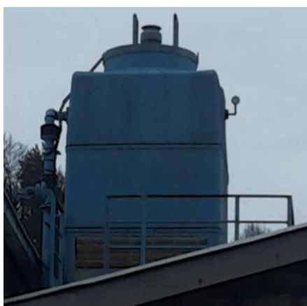
Slika 15: Hladilni stolp izven proizvodne hale programa hidroizolacij Vir: K. Novak, 2015
