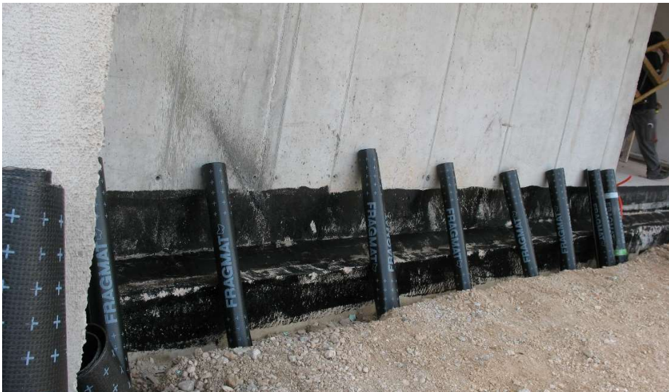
Slika 6: Posušen hladni bitumenski osnovni premaz na betonski steni in pripravljena površina za vgradnjo hidroizolacijskih trakov Vir: Fragmat Tim d.d., 2009
