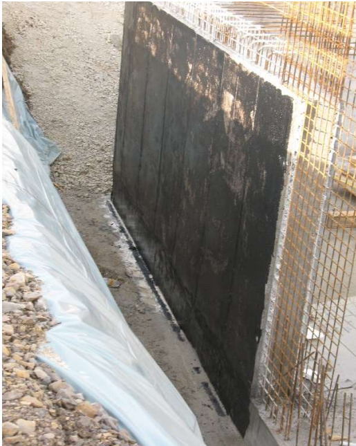
Slika 5: Nanesen hladni bitumenski osnovni premaz na betonsko površino Vir: Fragmat Tim d.d., 2009
