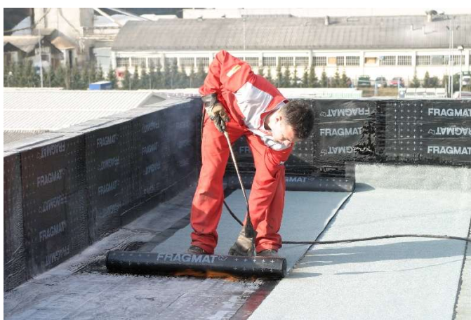
Slika 11: Vgradni postopek s pomočjo plinskega gorilnika Vir: Fragmat Tim d.d., 2013
