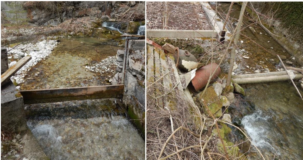
Slika 3: Odvzem in izpust vode male hidroelektrarne v zgornjem delu Suhega dola. Vir: M. Lenart, 2015
