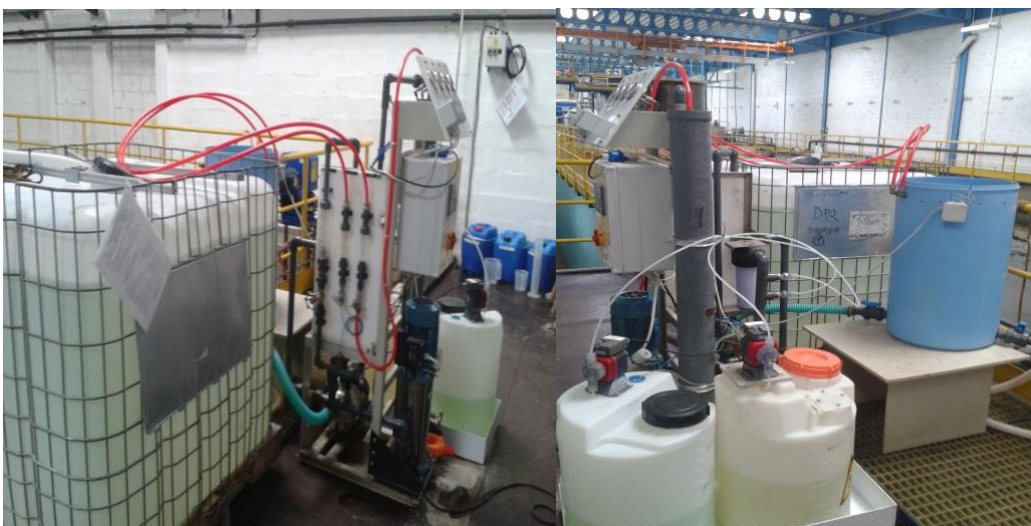
Slika 9: Pilotna naprava reverzne osmoze (RO)
