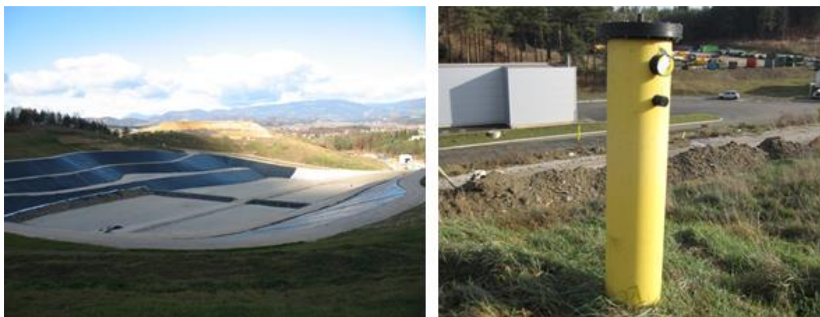
Slika 8: Odlagališče komunalnih odpadkov, plinska sonda (Vir: Interni vir RCERO Celje, 2009)
