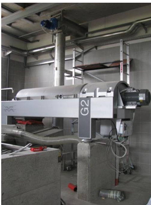
Slika 7: Centrifuga za obdelavo blata (Vir: JKP Žalec, 2013)
