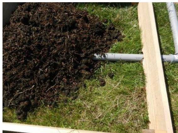
Slika 16: Perforirana cev na dnu kope (Vir: lasten, 2014)
