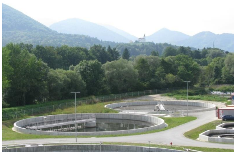
Slika 5: Sekundarna usedalnika (Vir: JKP Žalec, 2013)
