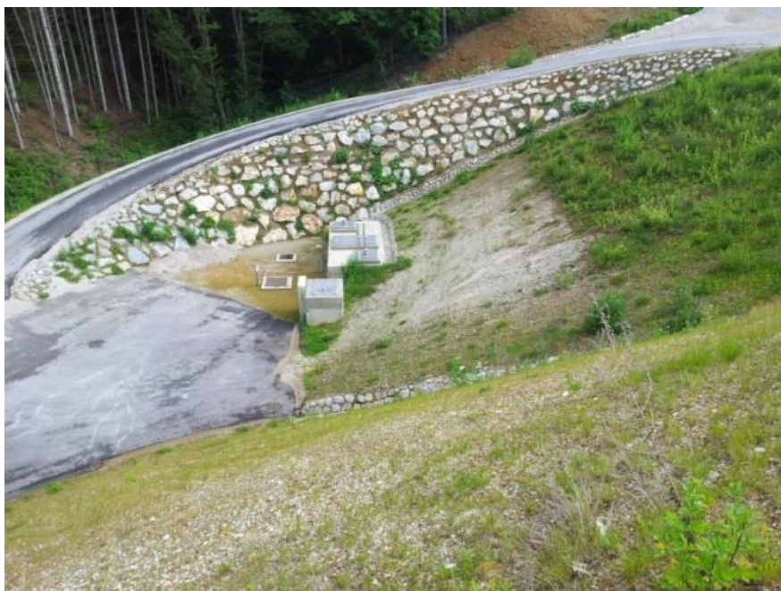
Slika 16: Črpalnišče izcedne vode na odlagališču ZMES (VIR: KOCEROD d. o. o., 2014, http://www.kocerod.si/ ).
