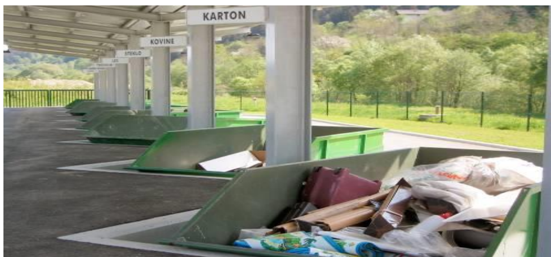
Slika 6: Zbirni center Pameče (VIR: JPK Slovenj Gradec, 2012).
