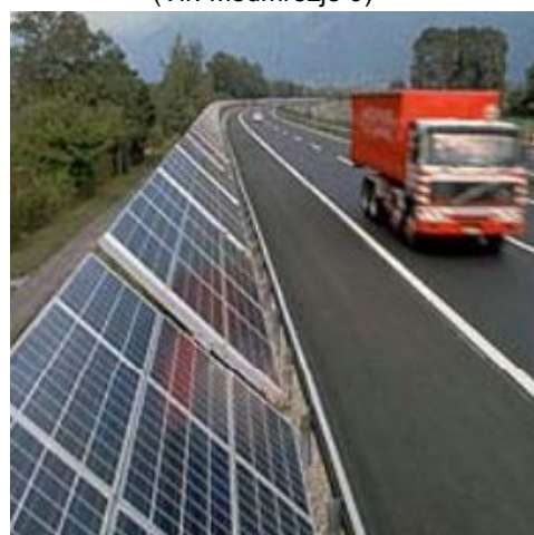
Slika 29: Sončni moduli na protihrupni ograji
