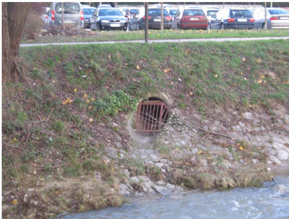
Slika 5: Iztok razbremenilnika Dijaški dom (Vir: Avtor, 2013)
