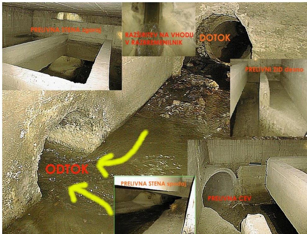
Slika 4: Razbremenilnik Dijaški dom – znotraj (Vir: Avtor, 2013)
