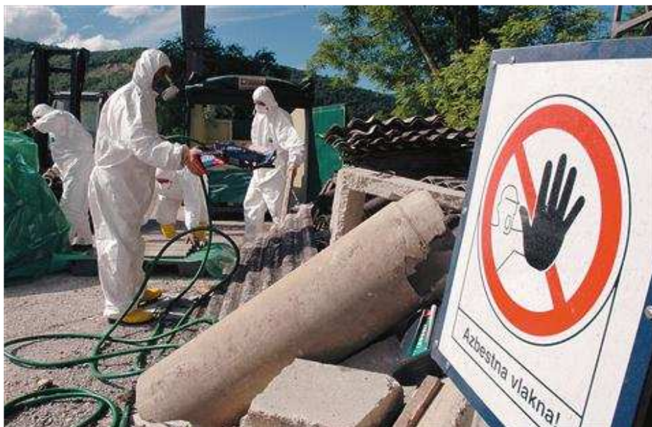
Slika 8: Pravilno odstranjevanje azbestno-cementnih plošč
