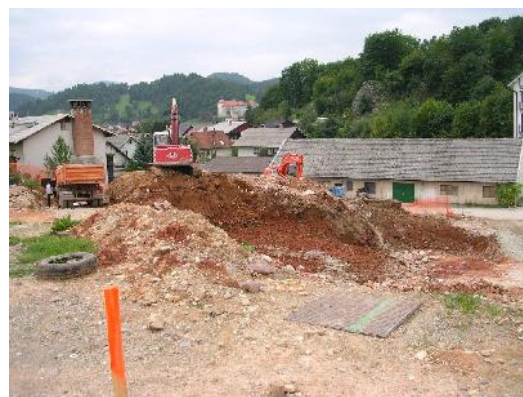
Slika 19: Odstranjevanje obstoječih objektov
