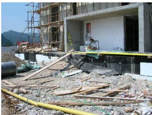
Slika 28: Gradbeni odpadki na gradbišču
