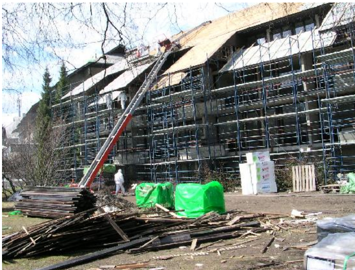
Slika 405: Odstranjevanje azbestne kritine in znak za odpadek, ki vsebuje azbest
