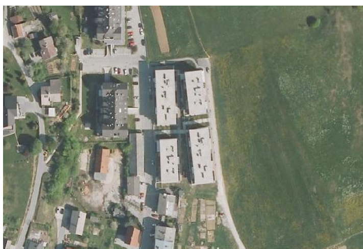
Slika 14: Orto-foto posnetek novozgrajenih objektov
