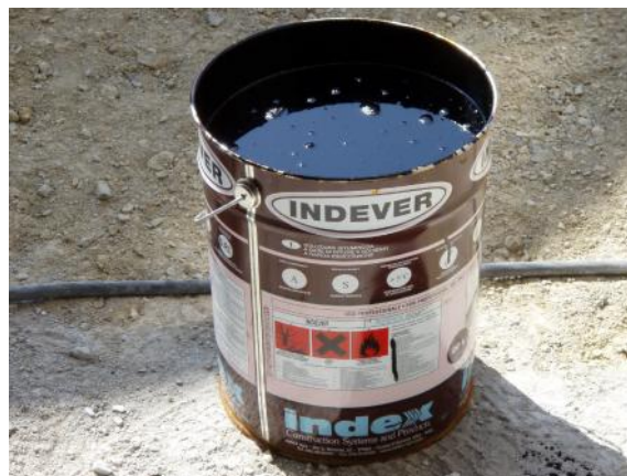
Slika 27: Nevarna snov na gradbišču
