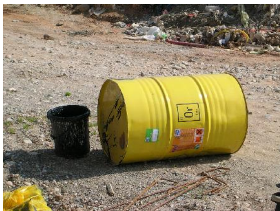
Slika 26: Nevarna snov na gradbišču
