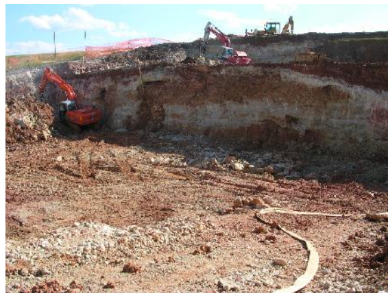
Slika 23: Izkop gradbene jame
