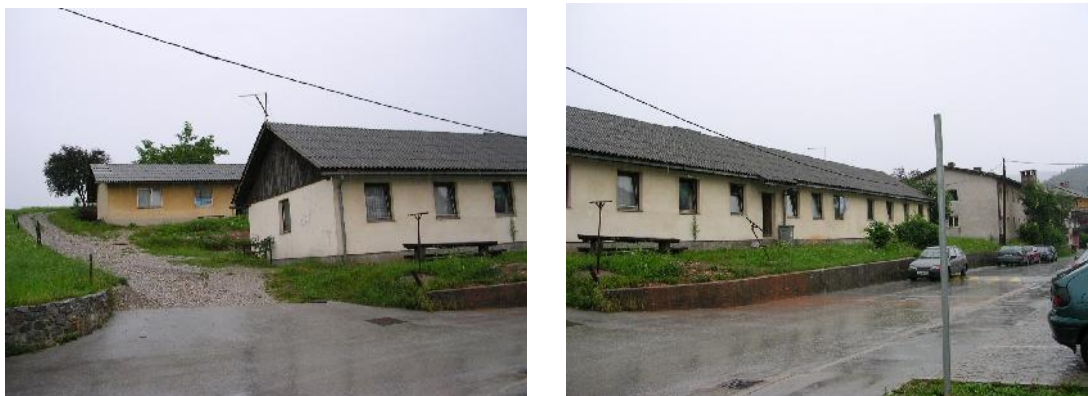
Slika 13: Obstoje i objekti pred posegom
