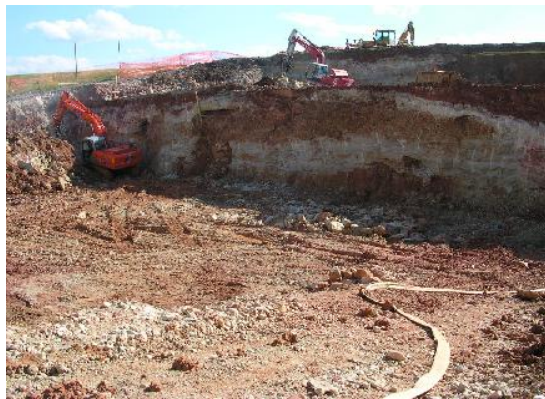
Slika 39: Vrtnje in rušenje skal z rušilnimi kladivi
