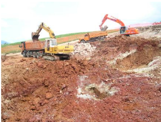
Slika 22: Izkop gradbene jame
