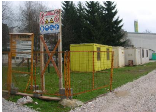
Slika 17: Objekti na gradbišču
