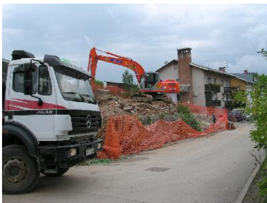
Slika 18: Odstranjevanje obstoječih objektov
