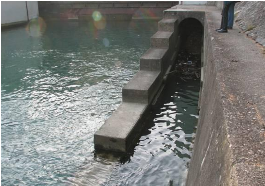
Slika 22: HE Dravograd – vhod v ribji prehod, povzeto po Kolman in Mikoš 2006
