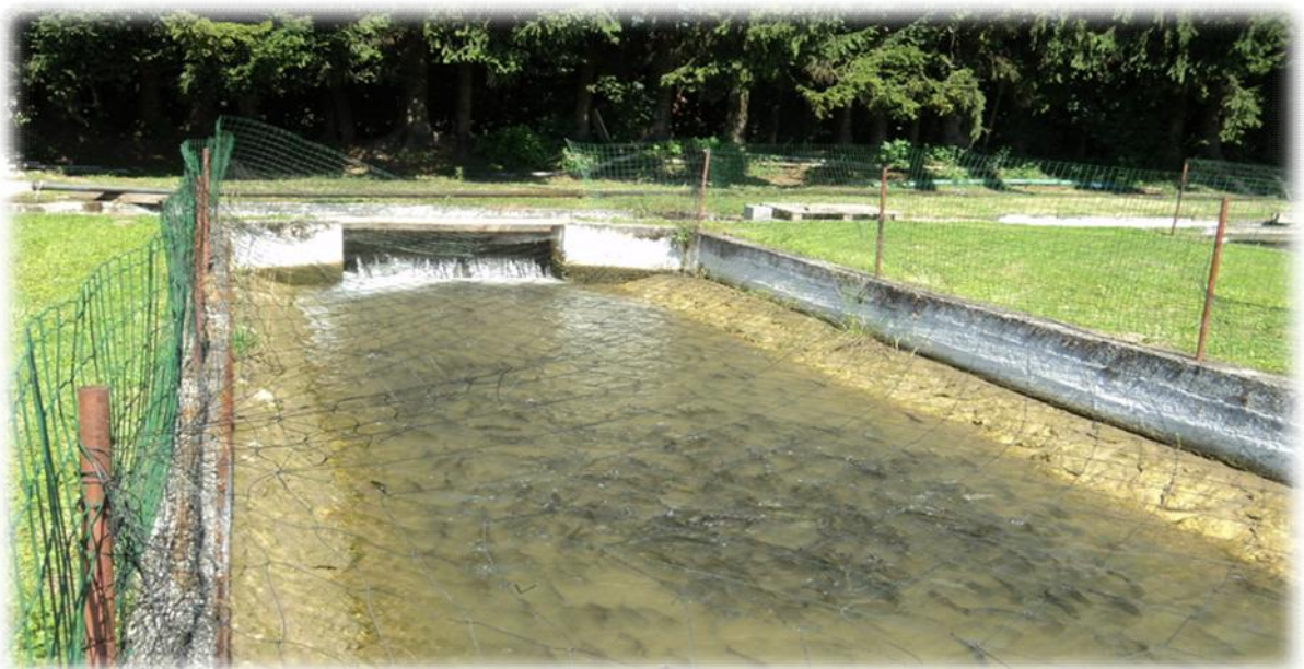
Slika 4: Vtok vode v betonski ribnik v Ribogojnici Žalec (B. Dragojevi , 2013)
