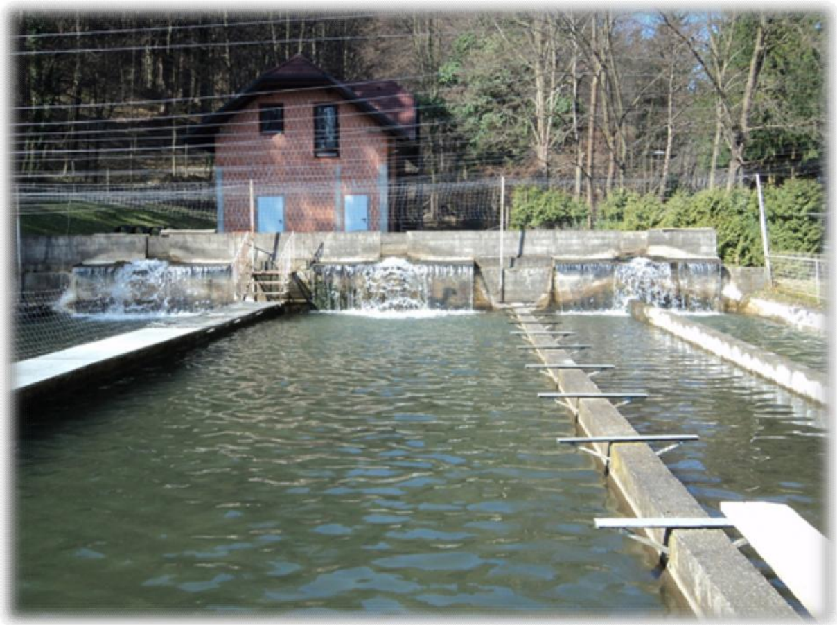
Slika 1: Vtok vode v betonski ribnik v Ribogojnici Fram (B. Dragojevi , 2013)
