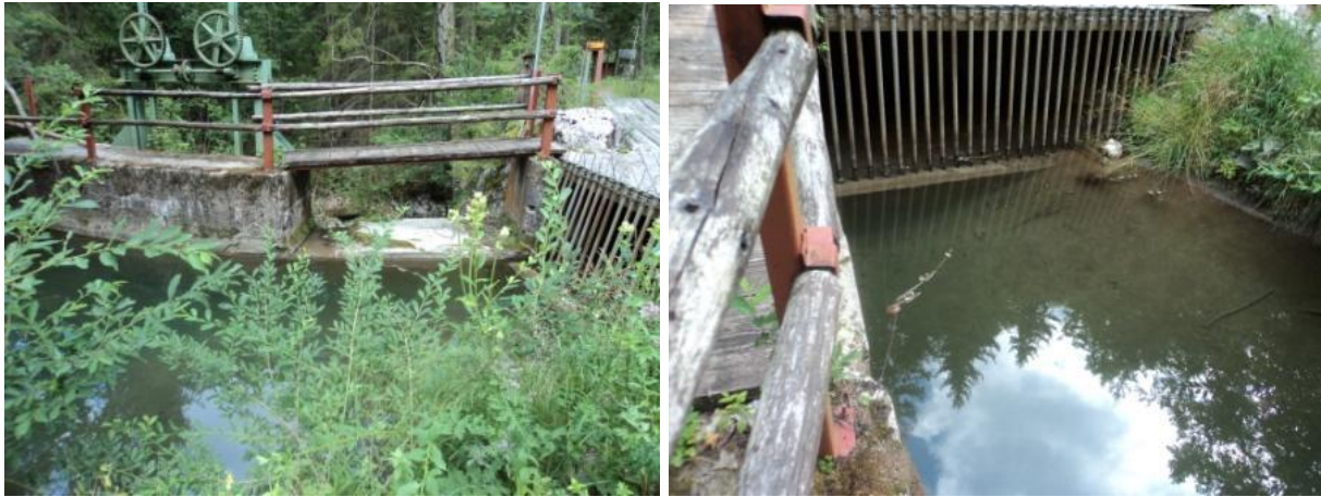
Slika 17 in 18: Groba rešetka (desno) in pregrada – MHE Topla, rna na Koroškem Vir: Mlinar Ana
