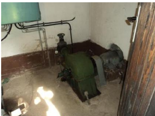
Slika 27: Strojnica (Peltonova enošobna turbina) – MHE Gosten nik, Ravne na Koroškem
