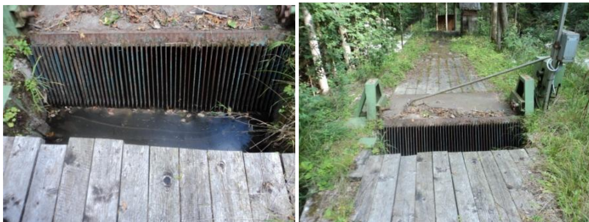
Slika 15 in 16: Gosta rešetka – MHE Topla, rna na Koroškem Vir: Mlinar Ana
