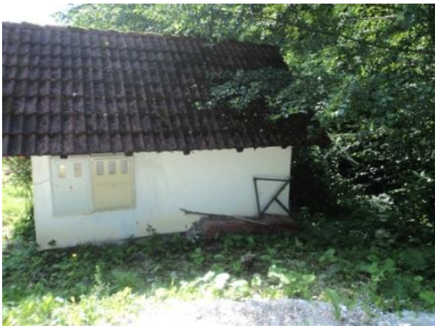
Slika 24: Strojnica – MHE Gostenjnik, Ravne na Koroškem
