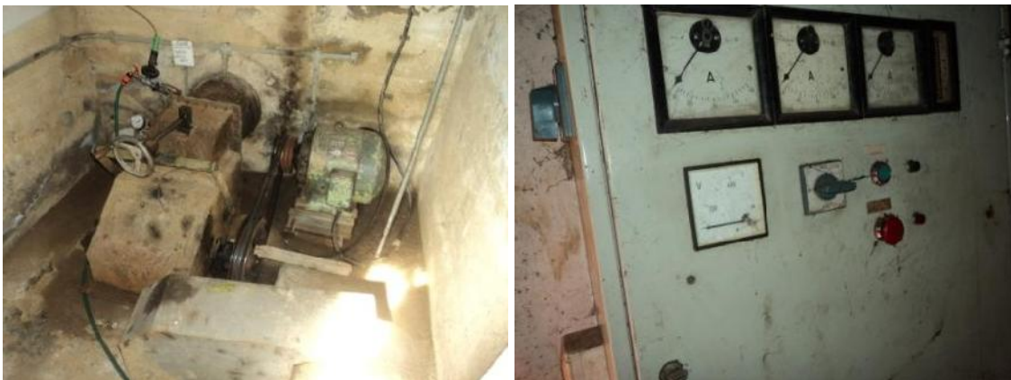
Slika 32: Strojnica MHE Prikeržnik (Bankijeva vodna turbina), Ravne na Koroškem
