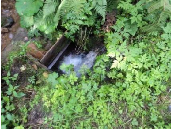
Slika 30: Iztok iz MHE Gostenik in hkrati zajem za MHE Prikeržnik, Ravne na Koroškem
