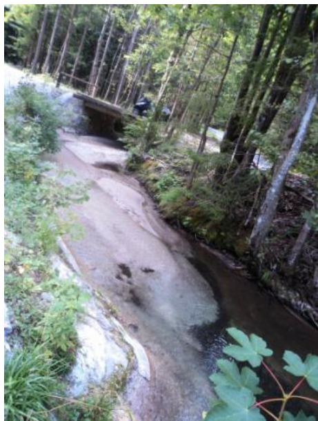
Slika 12: Naplavine peska, zajetje – MHE Topla, rna na Koroškem Vir: Mlinar Ana
