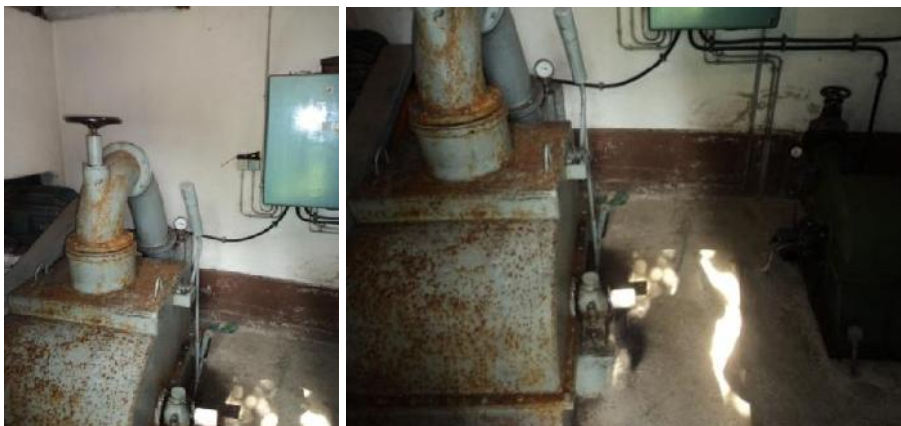
Slika 25 in 26: Strojnica (Peltonova dvošobna turbina – levo) – MHE Gosten nik, Ravne na Koroškem
