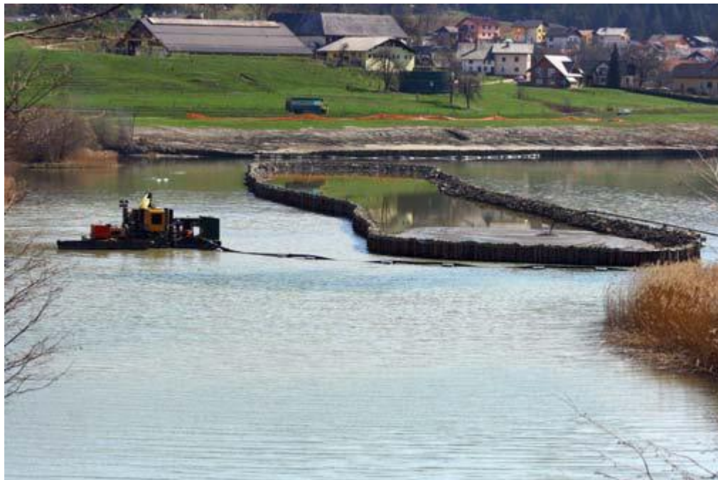
Slika 9: Gradnja umetnega otoka na Tilkovi mlaki (Vir: Čarf idr., 2012).
