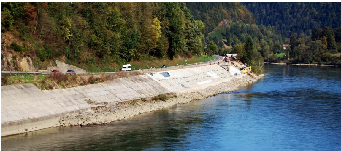
Slika 7: Umetna betonska brežina dolvodno od jezusa HE Vuhred in sanacija poplav iz leta 2012 (Vir: Avtor, 2013).
