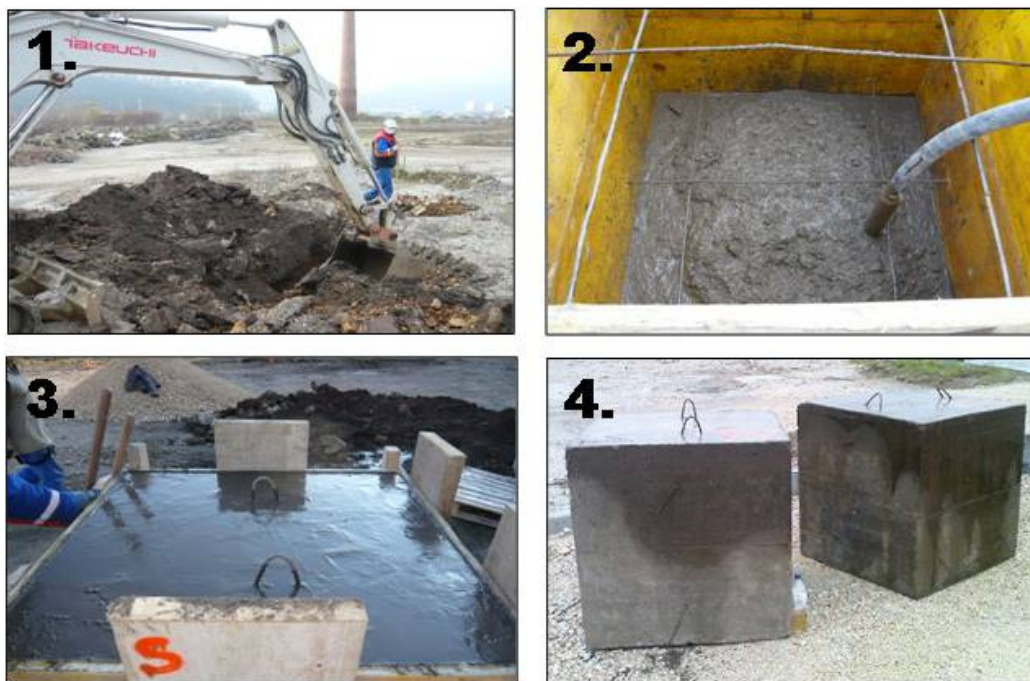
Slika 9: Pilotni poskus stabilizacije onesnažene zemljine s cementom. Izkop (1), mešanje zemljine s cementom (2), vlivanje stabilizirane zemljine v kalup (3), monolita stabilizirane zemljine (4) (vir: Leštan 2010).
