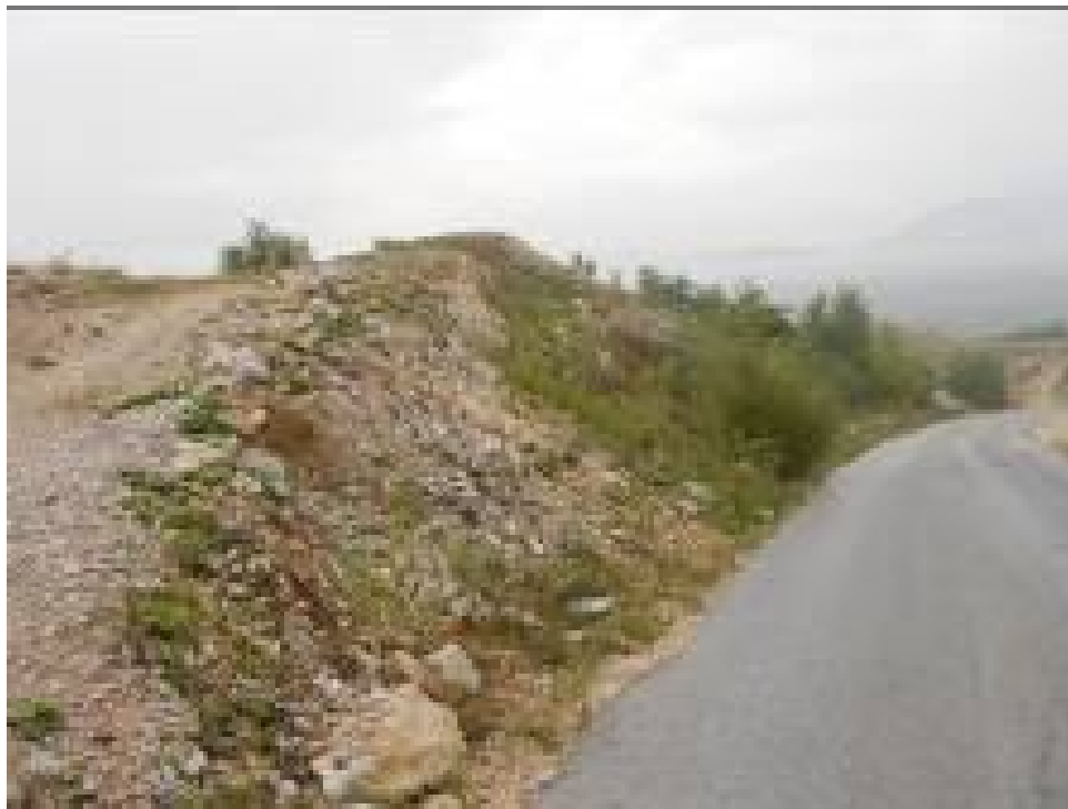
Slika 21: Izgradnja protihrupnega nasipa za območje Pernovo
