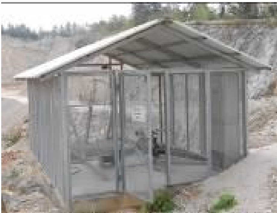
Slika 17: Črpališče tehnološke vode
