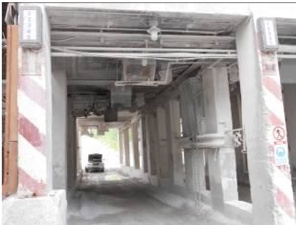
Slika 12: Silosi za agregat
