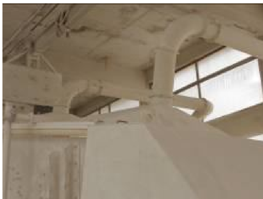
Slika 14: Odpraševalni sistem
