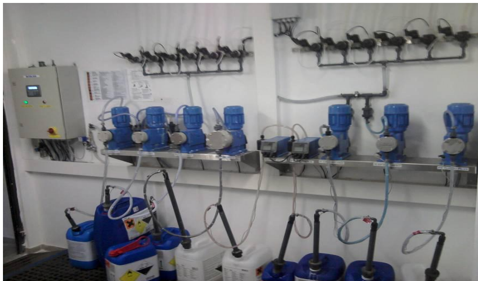
Slika 17: Novi sistem za doziranje pralnih in mehčalnih sredstev ter nevtralizacijskega sredstva Vir: Avtor, 2011.
