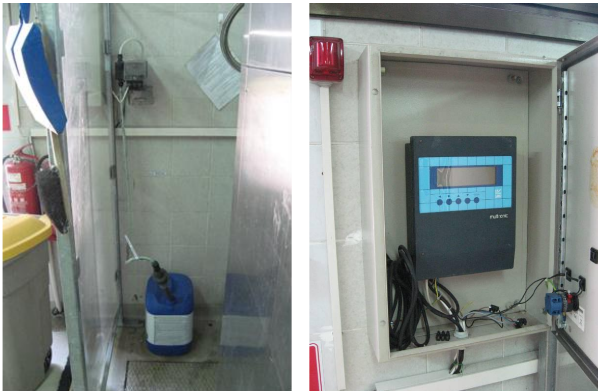
Sliki 14 in 15: Stari sistem doziranja nevtralizacijskega sredstva neposredno v jašek Vir: Avtor, 2011.
