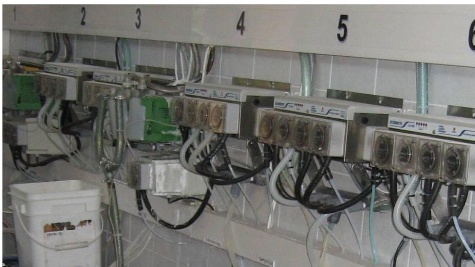
Slika 19: Stari sistem za doziranje pralnih in mehčalnih sredstev Vir: Avtor, 2011.
