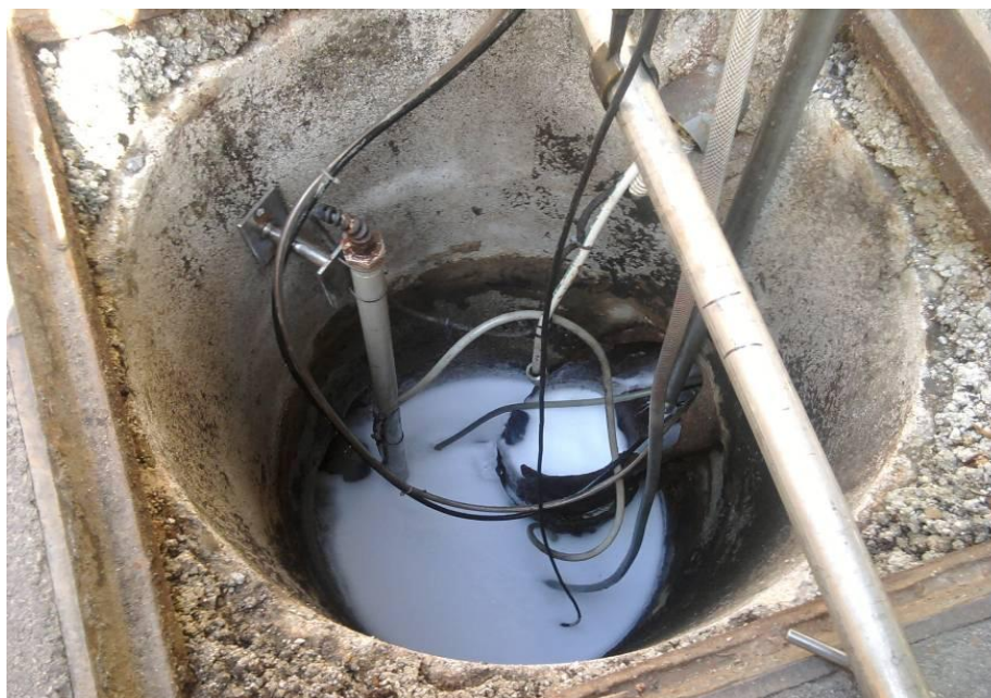
Slika 16: Nevtralizacijski jašek Vir: Avtor, 2011.
