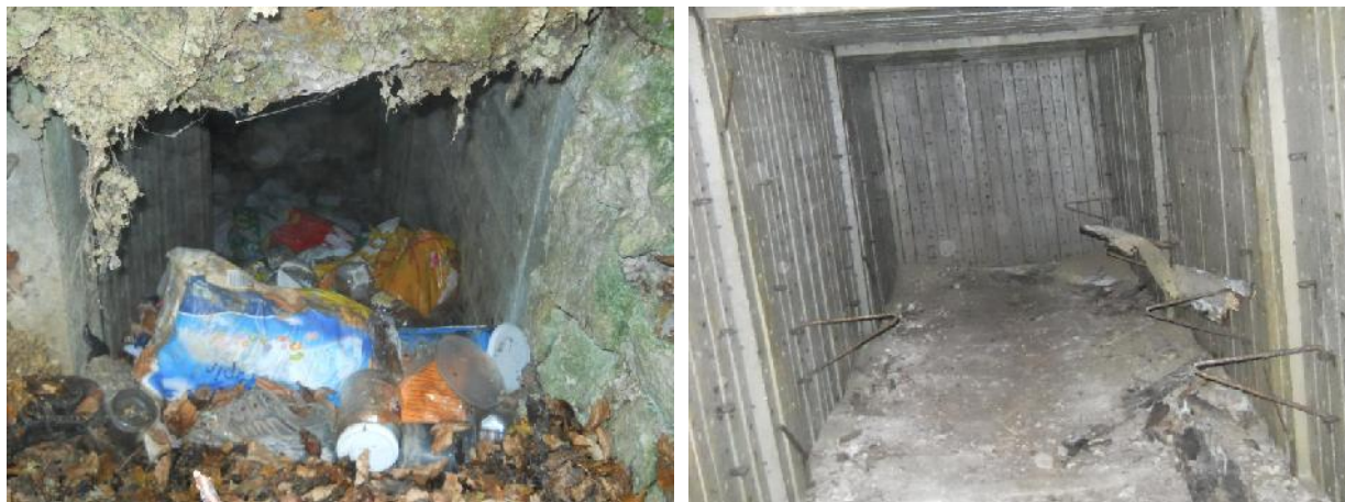
Slika 19: Divje odlagališ e na lokaciji Dolga Gora pred in po sanaciji (vir: Kos, 2012)
