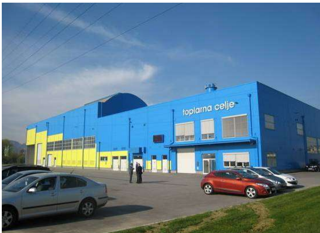
Slika 20: Zgradba Toplarne Celje
