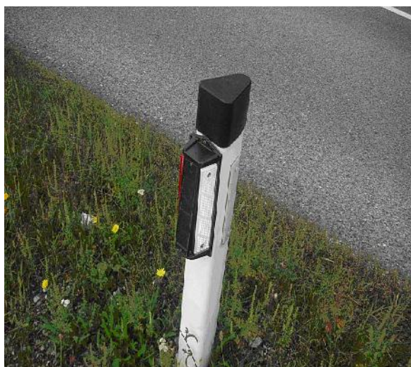
Slika 2: Zvo ne odvra alne naprave na obcestnem smerniku (stebri ku)
