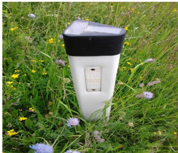
Slika 2: Zvo ne odvra alne naprave na obcestnem smerniku (stebri ku)
